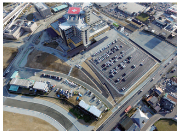
ドローンより新病院外観（平成 31 年1月）
