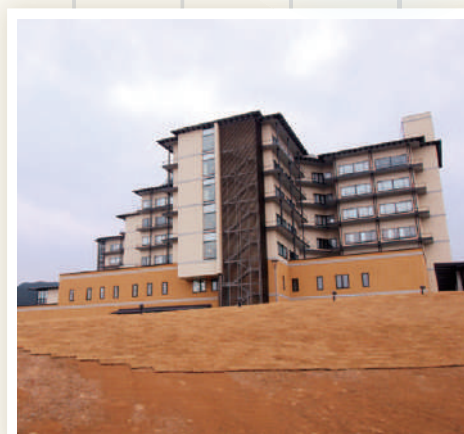
国道側より新病院外観
