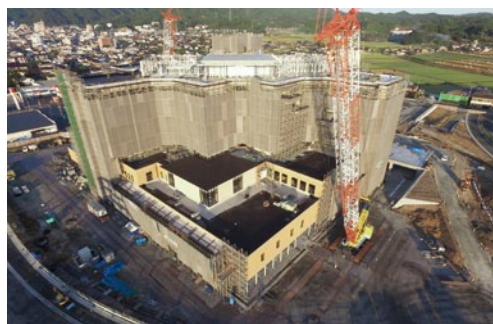
10月現在の様子。外観は完成し内装工事中 病院は2.5km先へ移動し4階建てから8階建てへ 敷地面積は115,500㎡から60,000㎡へコンパクト になります
